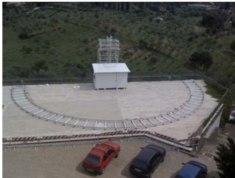
Fig. 2 – Sito d'impianto durante il montaggio
