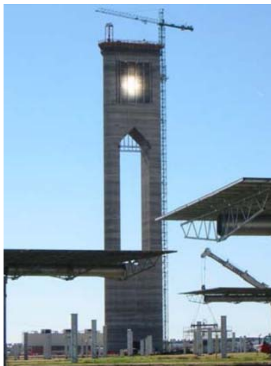
Fig. 2 – Veduta della torre solare dell'impianto PS10 (Siviglia, Spagna).
